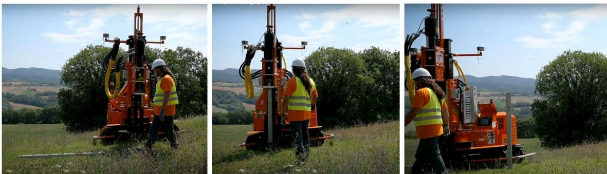
Slika 2.5 Postavljanje stupova s mehanizacijom (Izvor: Idejno rješenje)
